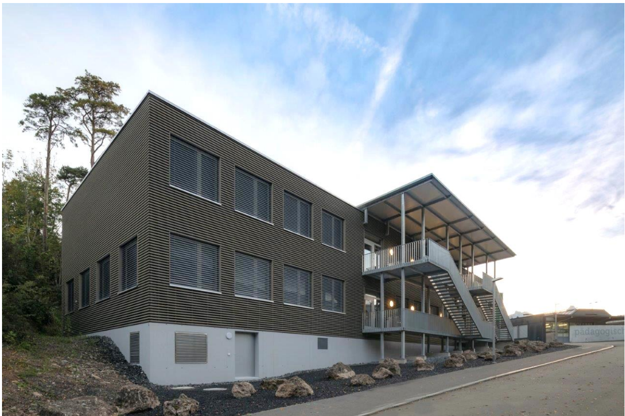
Bild: Schmidlin Holzbau
