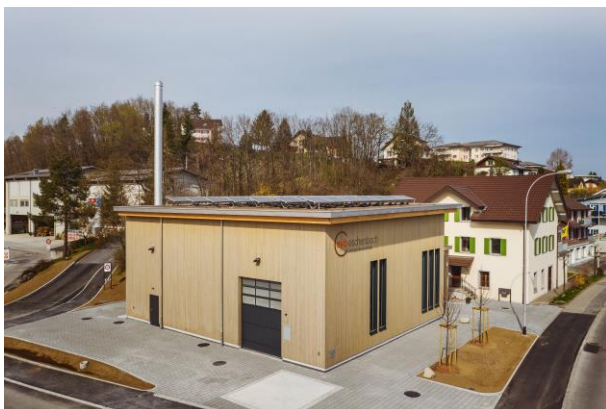
Das als Holzbau erstellte Gebäude bietet Platz für die erforderliche Heiztechnik des Wärmeverbundes Eschenbach LU.
