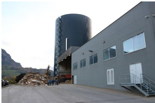
Beeindruckend: Im Hintergrund der 50 Meter hohe Turm, der die Wärmespeicherung übernimmt.
